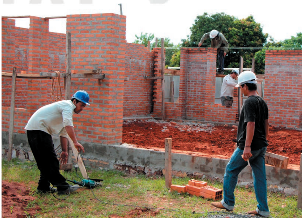
Construcción de Centro Comunitario en el Barrio Kamba Kua de Fernando de la Mora / Proyecto Mejoramiento de Barrio
