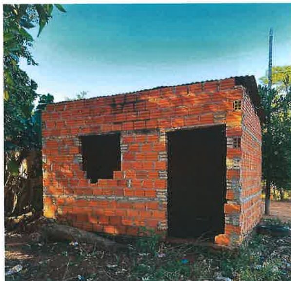
Comedor en proceso de construcción
